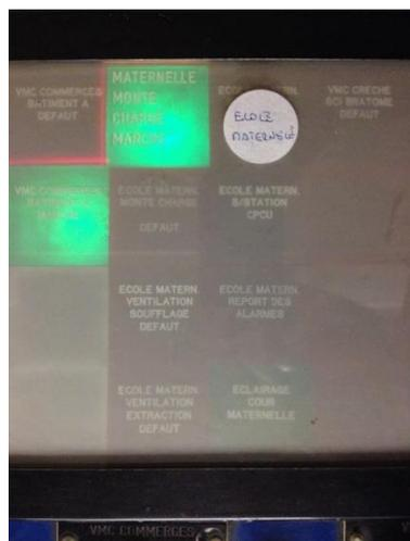
Voyants lumineux de surveillance des équipements privés de la Ville de Paris situés dans les locaux de l'ASL. Les alarmes en défaut s'allument en rouge afin de signaler un dysfonctionnement d'un appareil (monte-charge, ventilation, etc.)
